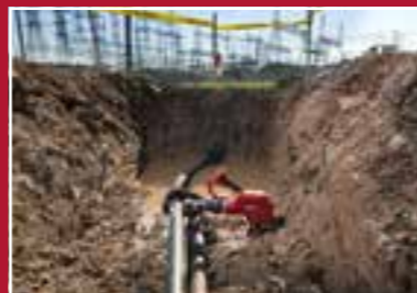
Otvorená konštrukcia čeluste poskytuje najjednoduchší prístup vo výkope
